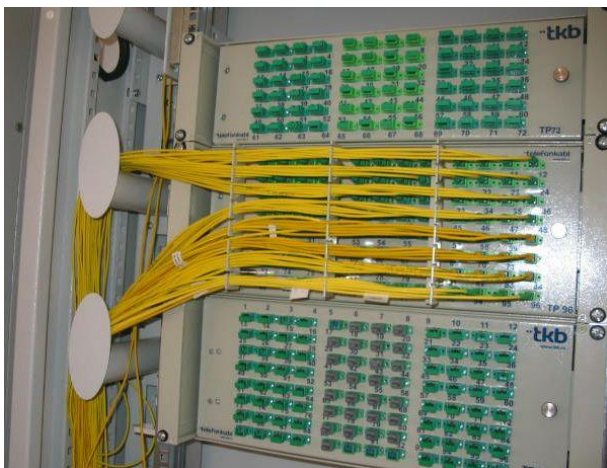
Sl. 8 Primer vodjenja prespojnih kablova
