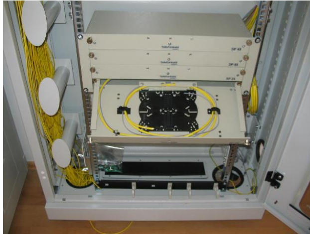
SI.5 Splajs paneli-primer montaže
