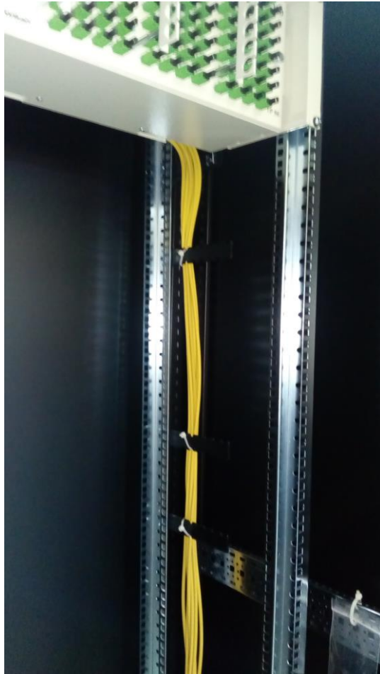
Sl.2 Primer bocnog vođenja kablova
